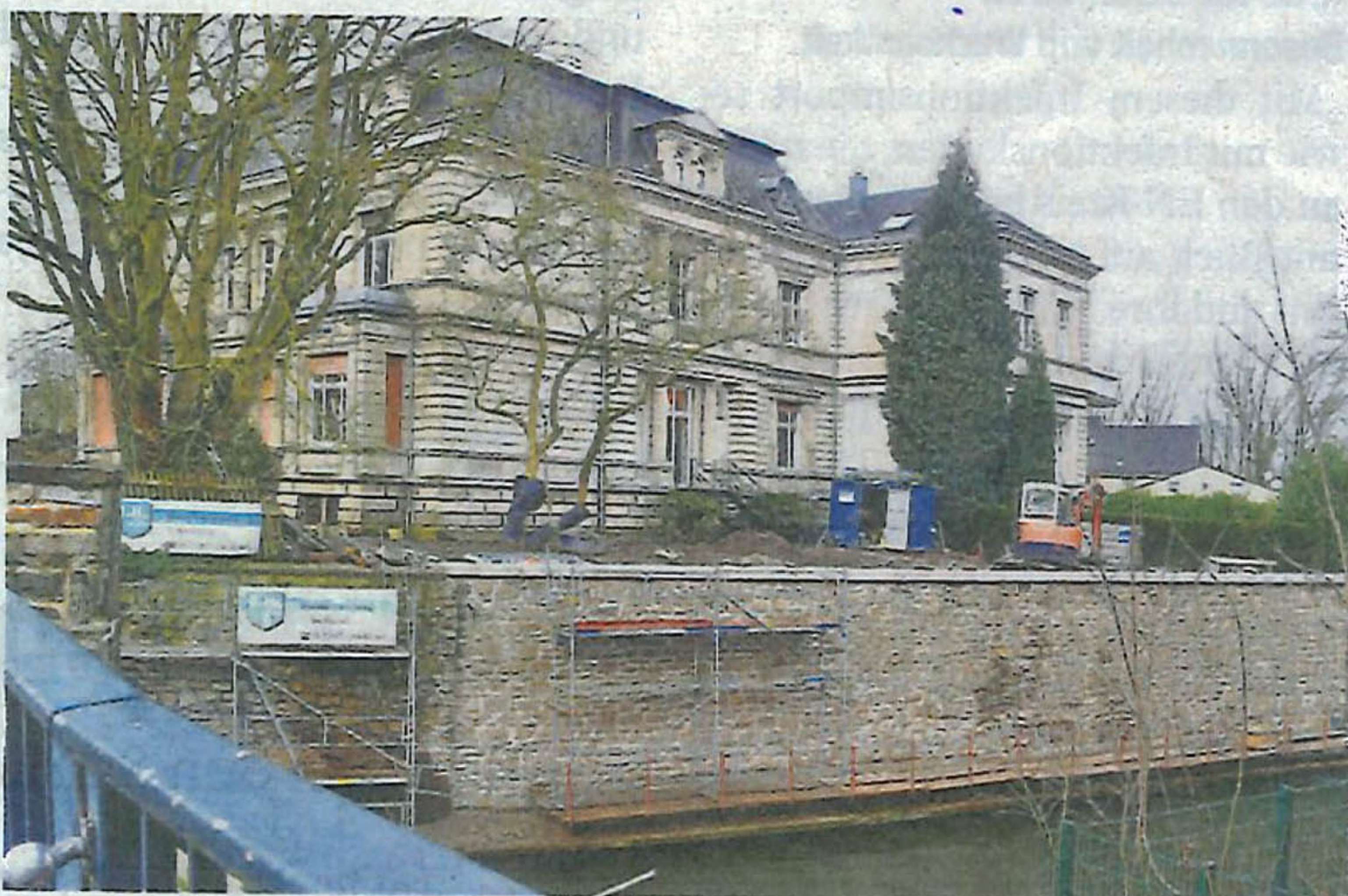
Die Mauer der Villa Ruhrtal zum Mühlengraben hin wird zurzeit in Handarbeit wieder aufgebaut.
